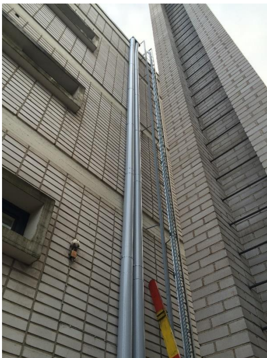
Kuva 7. Esimerkki toteutetuista LTO-putkista julkisivussa.
