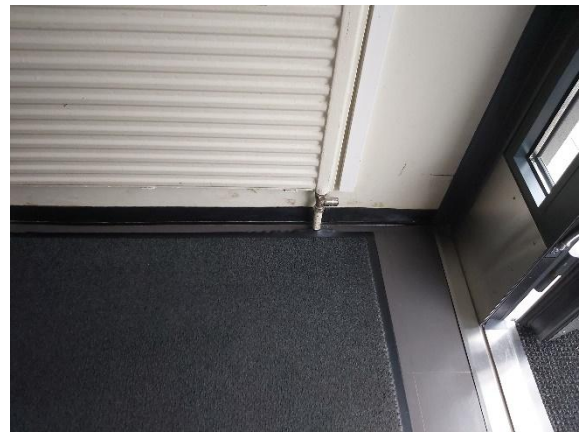
Kuva 4. Esimerkkikuva käsisäätöpyöräventtiilistä.
