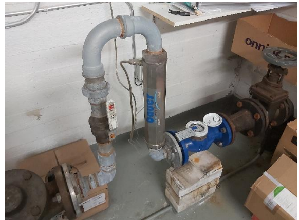
Kuva 6. Käyttövesiverkoston on asennettu Bauerin vedenkäsittelylaite.
