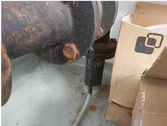
Kuva 5. Tonttivesijohto on alkuperäinen ja se on materiaaliltaan valurautaa.
